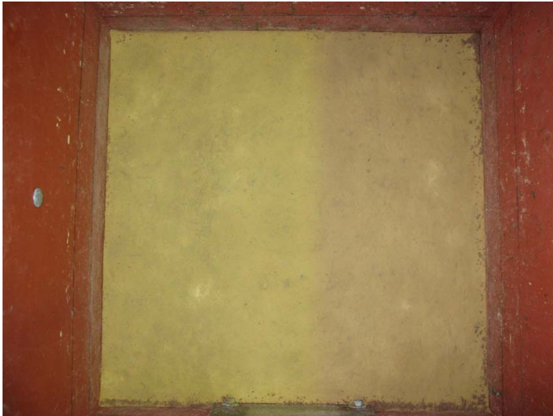
Abb. 8: Trennschicht (Oberfläche des Löss) des Versuchs d (Geogitter mit Vliesstoff mit Vibration) nach dem Ausbau des Geogitters mit Vliesstoff
