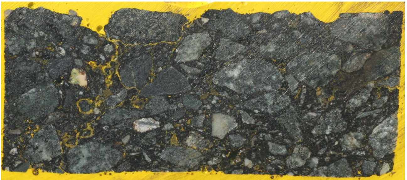
Abb. 8: BK14 L1 R – Im linken Teil des Bildes ist der Asphalt im Bereich des Epoxidharzes sehr inhomogen.
